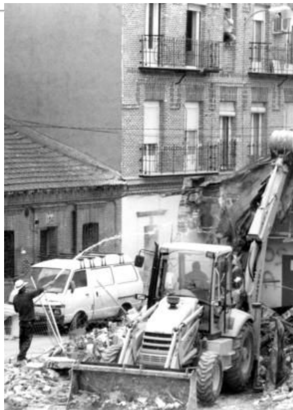
Hormigón armado. El 80% de las bajas por accidente en la construcción en 2002 afectó a trabajadores temporales. Aut: Bárbara Boyero.
